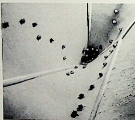
Bild 2. Bis in die Spitze beider Türme reichen die „Lautsprecherwege“ aus Mittel/Hochtonlautsprechern für die Wiedergabe der elektronischen Musik und der Geräusche, eingehüllt in staubsichere, schalldurchlässige Hauben
